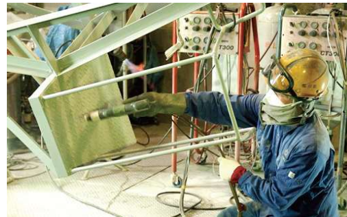
▲滑り止め加工の作業
