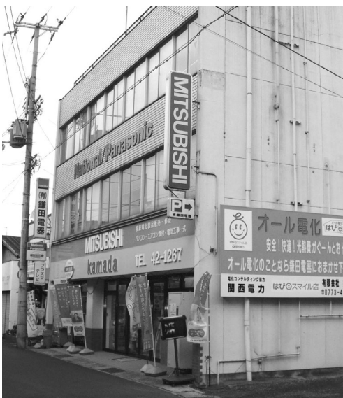
平成14年にオープンした3階建ての現店舗
